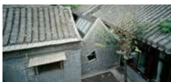
Maîtrise d'ouvrage Privé
