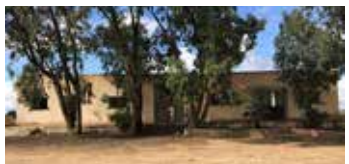
Maîtrise d'ouvrage Privé
