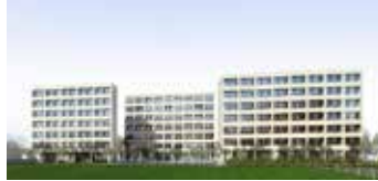
Maîtrise d'ouvrage Commune de Vernier
