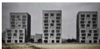
Maîtrise d'ouvrage Kunshan Haokang Ltd.
