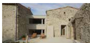
Maîtrise d'ouvrage Privé
