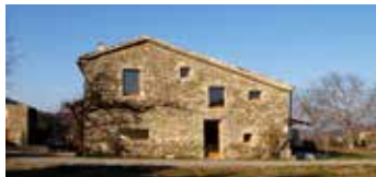
Maîtrise d'ouvrage Privé
