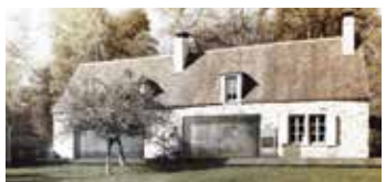
Maîtrise d'ouvrage Privé
