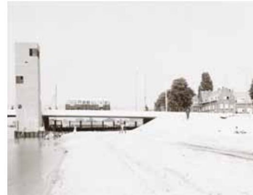
Terreinwerkzaamheden bij het Kraaijenplein (1966) Site work at Kraaijenplein (1966)
