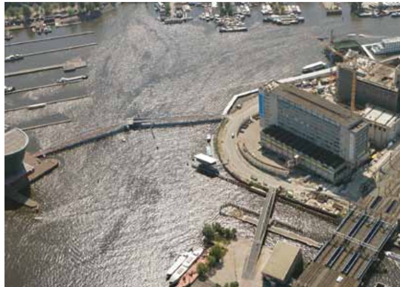
Luchtfoto van het Oosterdok, in het water de brugwachterspost (2006) Aerial view of Oosterdok, in the water the bridge operator station (2006)
