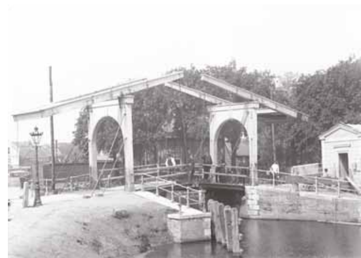
Kattenslootbrug met voormalig houten brugwachtershuis (1890) Kattenslootbrug with former wooden bridge house (1890)
