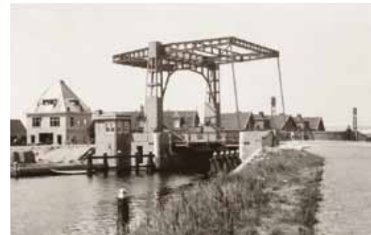
De Weespertrekvaart met de voormalige Duivendrechtsebrug en stenen brugwachtershuis Weespertrekvaart with the former Duivendrechtsebrug and brick bridge house
