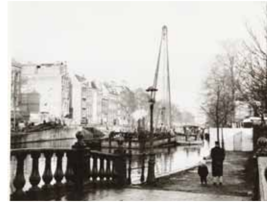
Op de achtergrond de Hortusbrug in aanbouw. Rechts achter de bomen het brugwachtershuis (1958) In the background the Hortusbrug under construction. The bridge house on the right behind the trees. (1958)
