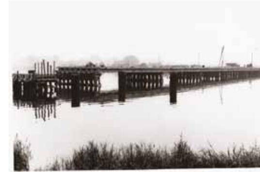
Bouw van de Langebrug Langebrug under construction
