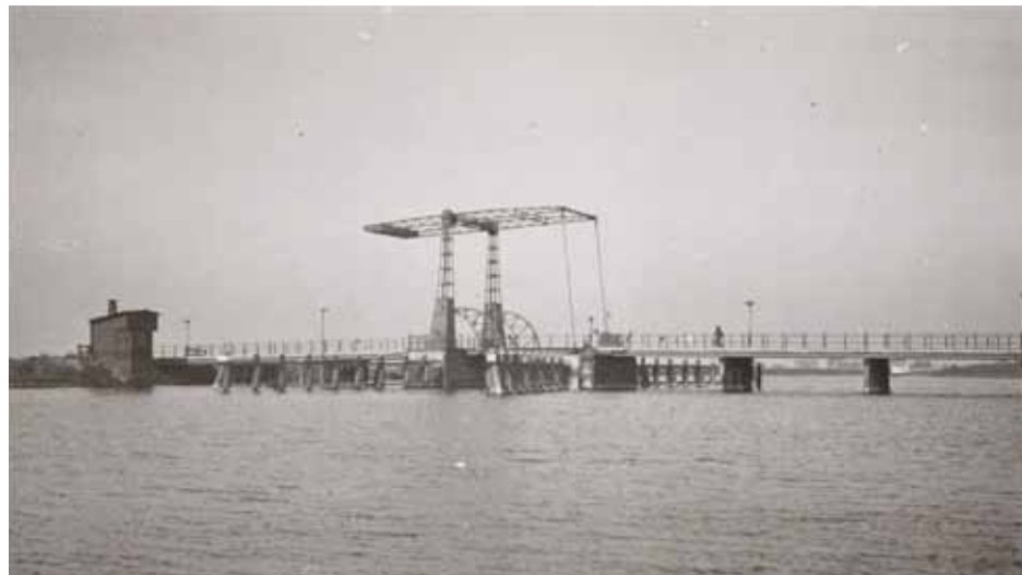
Oude langebrug met links een houten brughuis (1922) Former bridge with the wooden bridge house on the left (1922)
