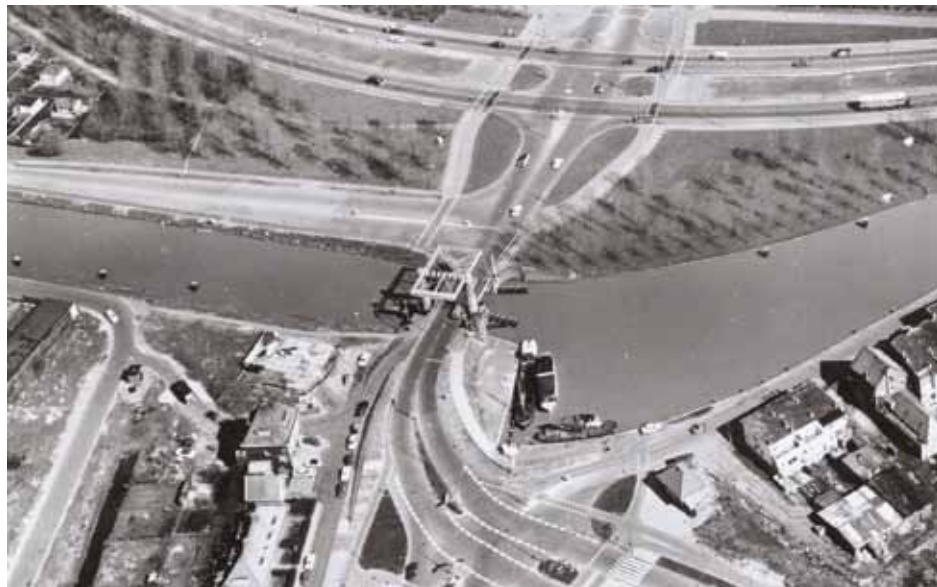
Luchtfoto in noordelijke richting met in het midden de Duivendrechtsebrug Aerial view, northbound with Duivendrechtsebrug in the middle
