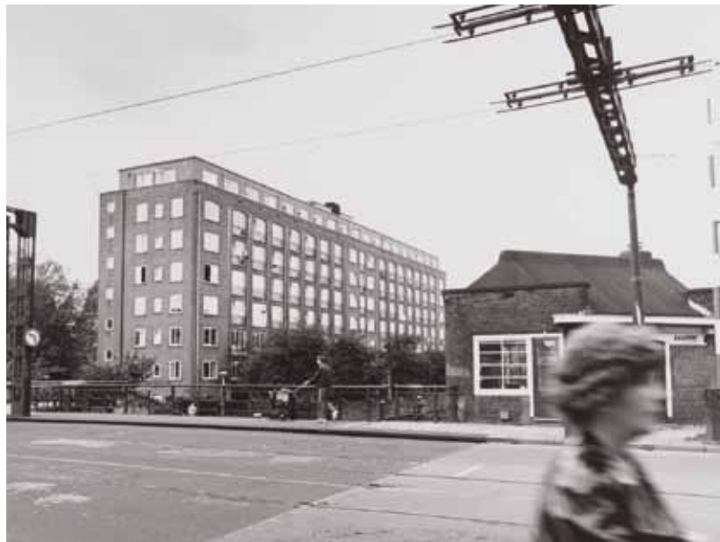
Wiegbrug met het oude bakstenen huisje van P.L. Kramer (1987) Wiegbrug with the old brick bridge house by P.L. Kramer (1987)
