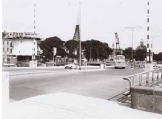
Het Kortjewantshuis tijdens de bouw (1968) The Kortjewants house during construction (1968)
