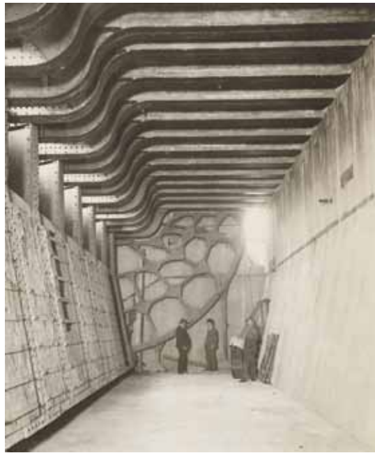
De basculekamer van de Wiegbrug (ca. 1930) The bascule chamber of the Wiegbrug (ca. 1930)
