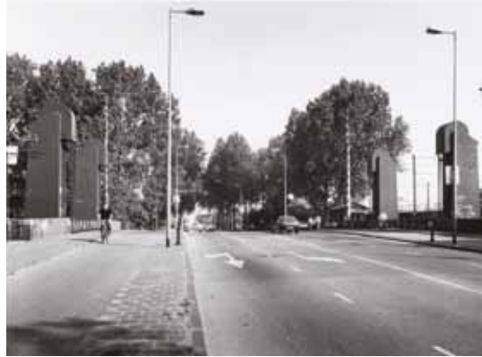
De Omvalbrug gezien vanaf de Spaklerweg (1992) Omvalbrug seen from Spaklerweg (1992)
