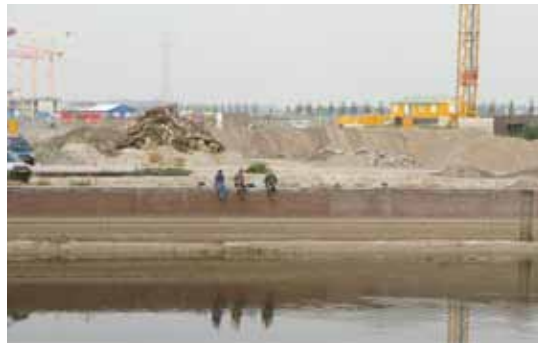
Bouwwerkers op de westelijke kademuur van de haven op het Haveneiland (2006) Construction workers on the western wall of the harbour at Haveneiland (2006)
