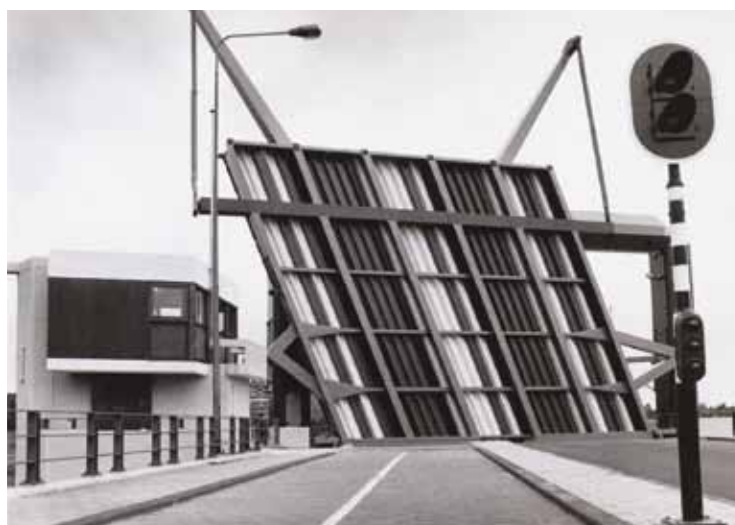
Het schuin geplaatste brugdek van de IJdoornbrug met brugwachtershuis (1983) The angled deck of IJdoornbrug with bridge house (1983)
