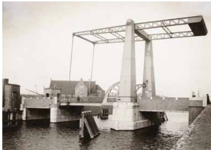
Oorspronkelijke ophaalbrug met stenen brughuis (1929) Original drawbridge with stone bridge house (1929)
