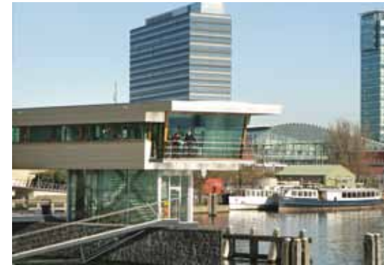
De brugwachterspost met uitkijkende brugwachters (2009) The bridge operator station with bridge operators on the look-out (2009)
