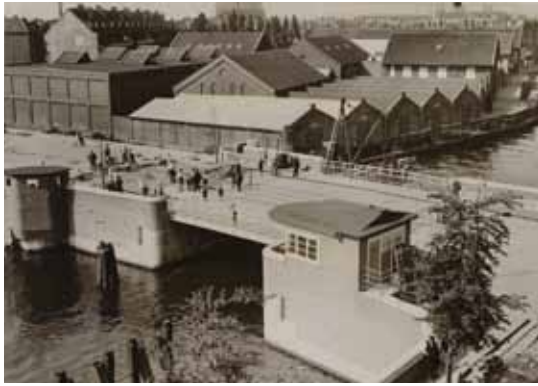
Bouw van de van Hallbrug (ca. 1932) Construction of Van Hallbrug (ca. 1932)
