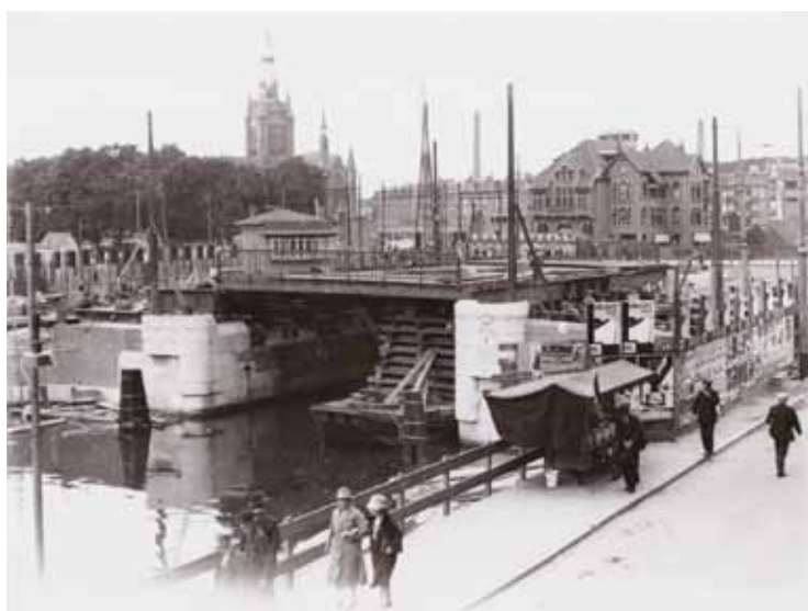
De bouw van de Willemshuis gezien vanaf de Singelgracht (1928) The construction of Willemshuis, seen from the Singelgracht (1928)
