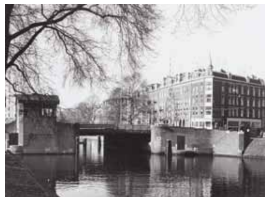
Kattenslootbrug gezien vanaf de Catskade (1983) Kattenslootbrug seen from the Catskade (1983)
