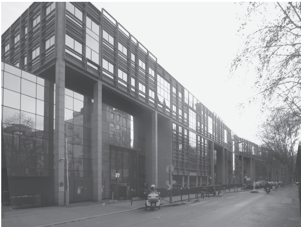
Bâtiment avant travaux
