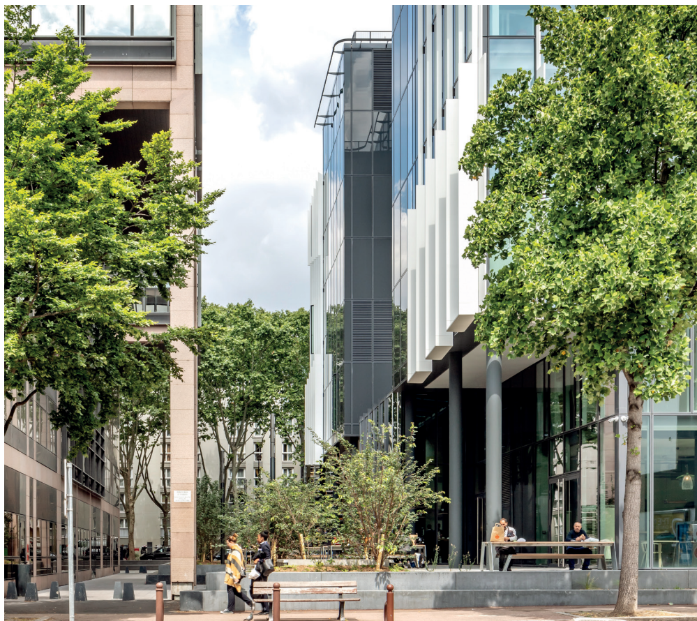
Détail du traitement des abords de Shift, côté restaurant
