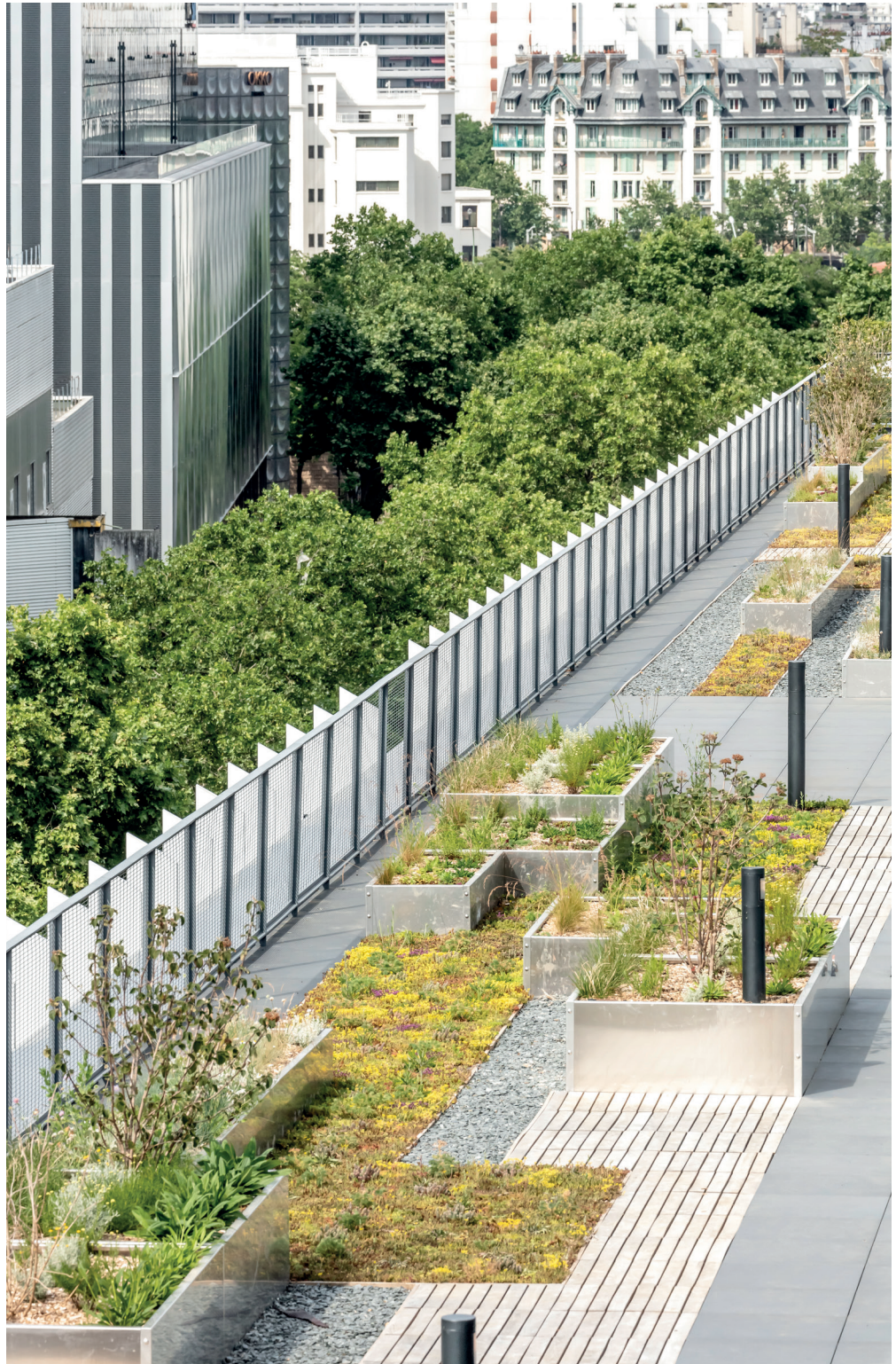
Terrasse accessible depuis les espaces de bureaux
