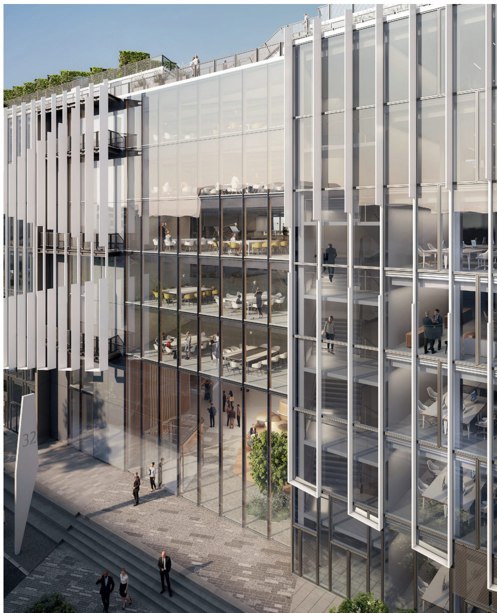
L'accès de la rue intérieure, vitrée sur toute la hauteur du bâtiment
