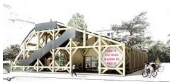
Maîtrise d'ouvrage Commune de Villeurbanne
