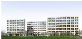
Maîtrise d'ouvrage Commune de Vernier
