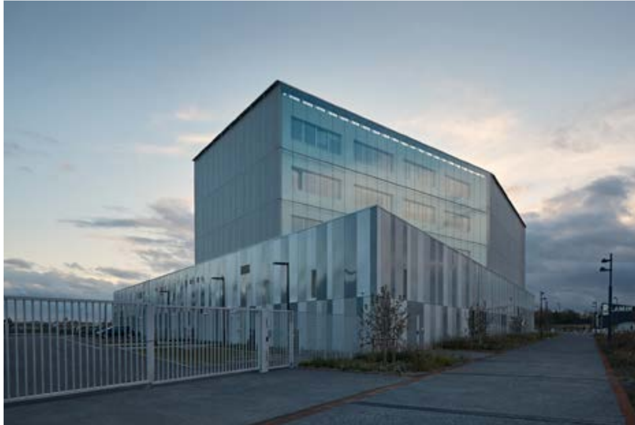
Vue nord-est du bâtiment qui permet de voir l'intégralité des matériaux de façade.
