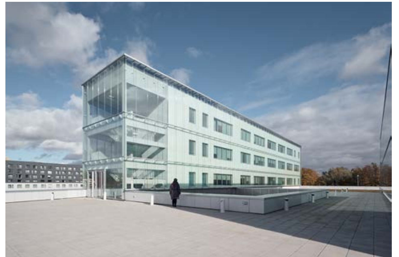
Emergence dédiée aux enseignements de l'IIM et entourée de la terrasse promenade accessible au public
