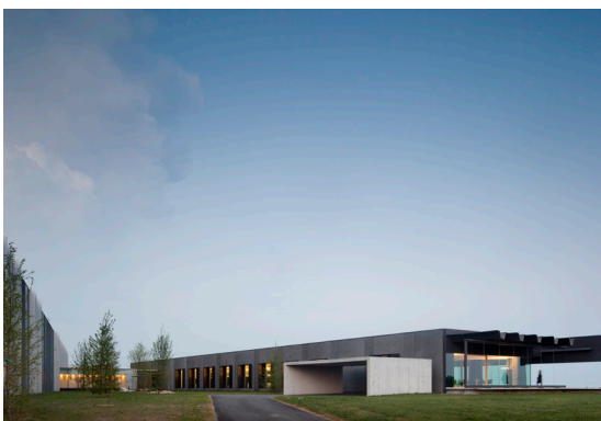
7. Pratic 1.0, Fagagna (UD), 2011 Sede operativa e produttiva. L’area verde fra i due edifici perpendicolari (uno per uffici, l’altro per la produzione) è pensata come spazio ricreativo per i lavoratori.
