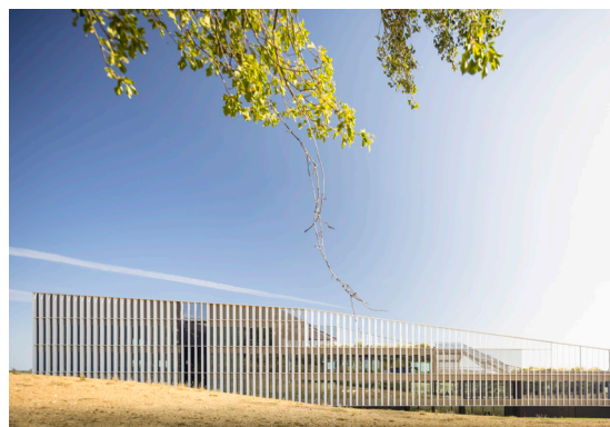
12. Furla Progetto Italia, Tavarnelle Val di Pesa (FI), 2021 Sistema di facciata in lamelle verticali disposte secondo l'orientamento solare.
