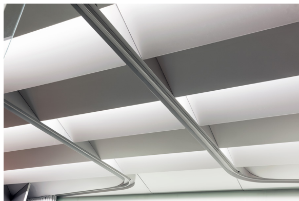
détail plafond avec coulisses pour rideaux
