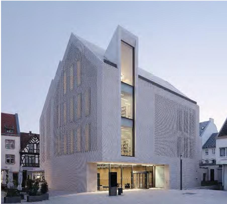
**Ein Monolith, bis ins Giebeldach aus hellem Klinker bestehend, der sich sensibel an das historische Rathaus anlehnt. Die Anordnung aus versetzt stehenden Baukörpern und ineinander verzahnten Satteldächern sowie die Auslassungen im Klinker geben dem ergänzenden Neubau Leichtigkeit. Der rückseitig angrenzende Janshof wird zum gestalteten Stadtplatz. Foto Bibliothek: Taufik Kenan**
